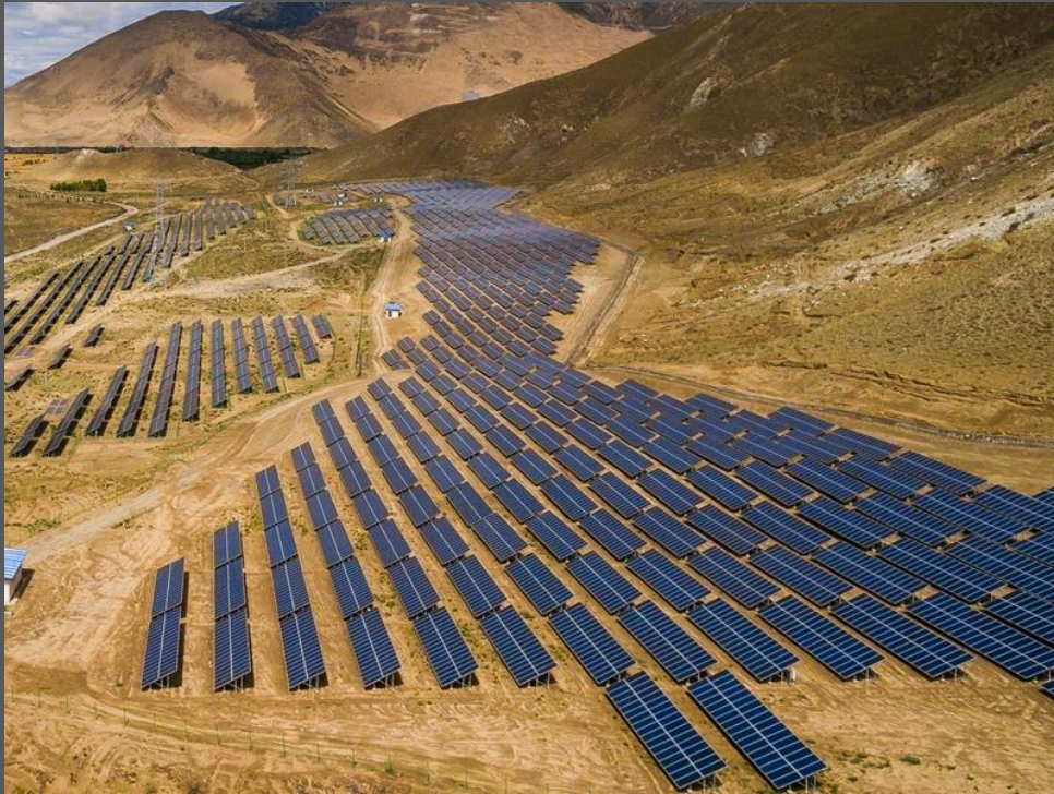
图 1 中国西藏一个20MW的光伏电站 (Fig.1 A 20 PV Plant in Tibet China)
